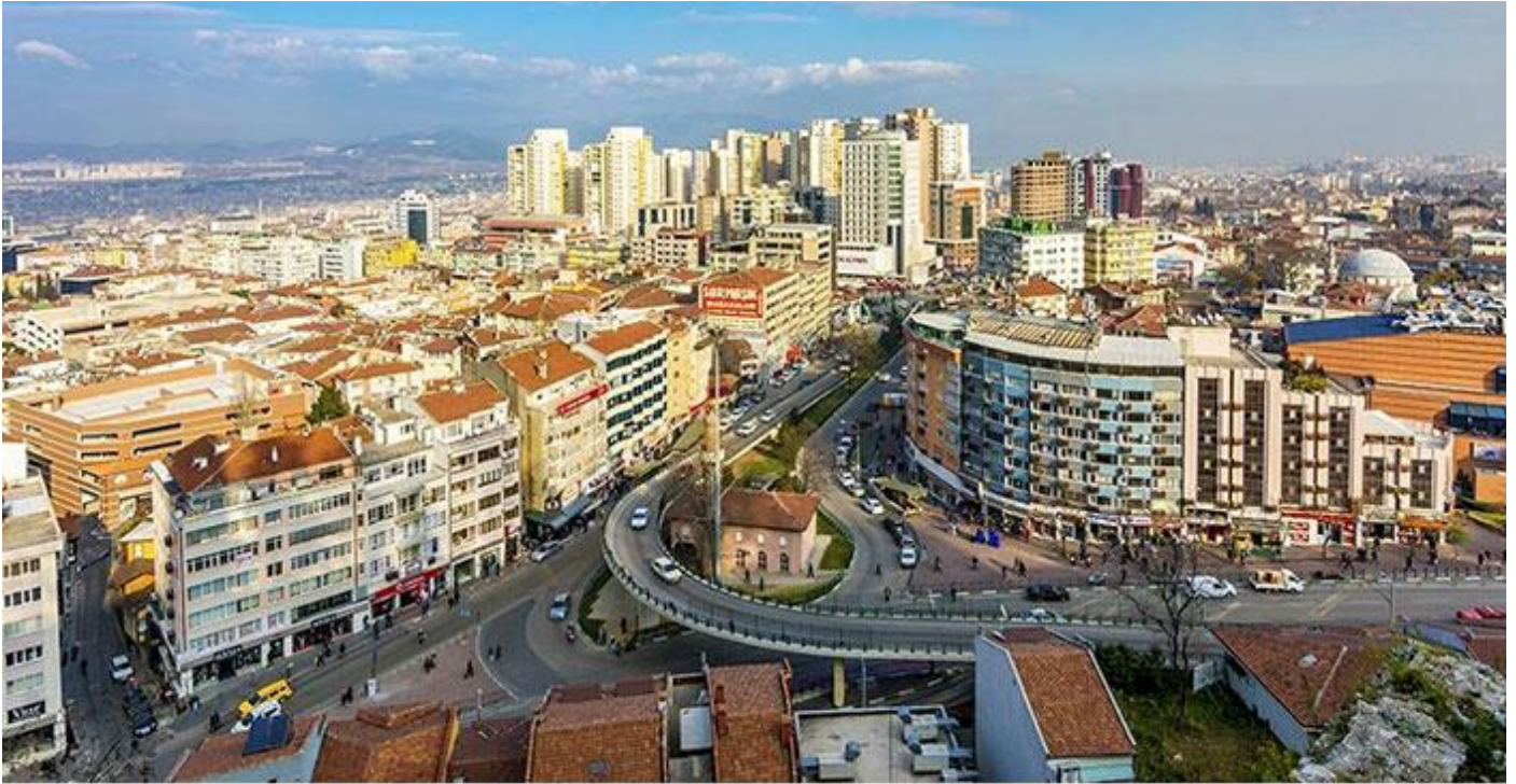
Bursa'nın gelişmesinde önemli ulaşım yolları üzerinde bulunmasının etkisi vardır.
